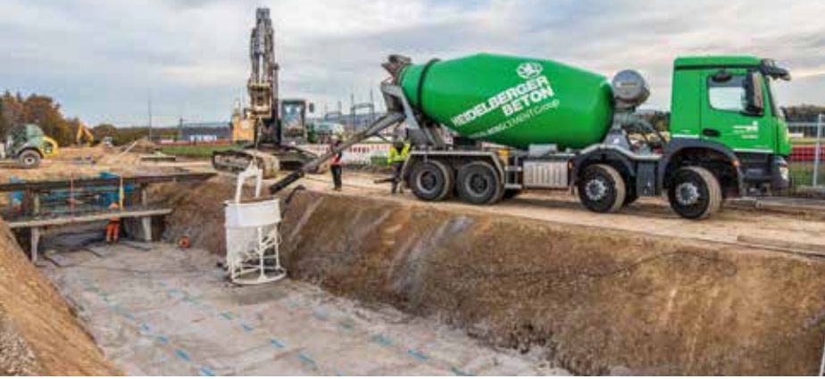
← Erdkabeltrasse, Bacharach Foto: HeidelbergCement AG/Steffen Fuchs
